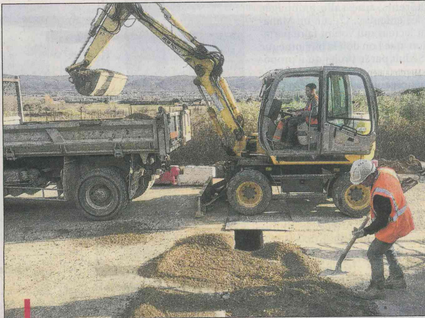
Le chantier, en cours sur la commune, prendra fin ce printemps.
