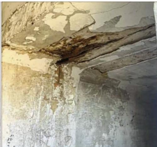
Intérieur du bâtiment la Turbine à Manosque, laissé complètement à l'abandon depuis des années. Ici à droite, le plafond de l'entrée souffre d'infiltrations importantes. "Un état de délabrement avancé", regrette Clément Guiot.
