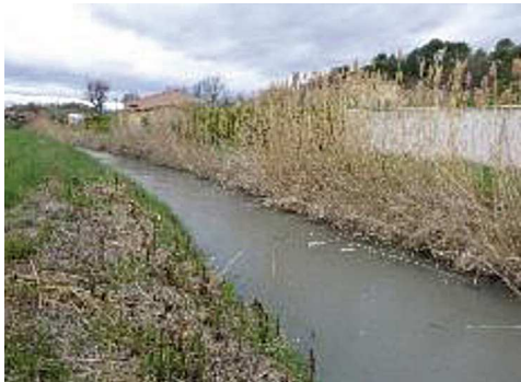
Une berge du canal inaccessible avec une épareuse classique
