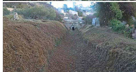
Une portion du canal maître à Peyruis, avant et après fauchage
