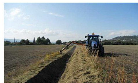
Eparage du canal maître par l'entreprise BOURRELLY
