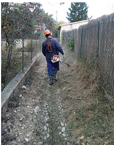
Débroussaillage manuel d'une filiole enclavée à Villeneuve
