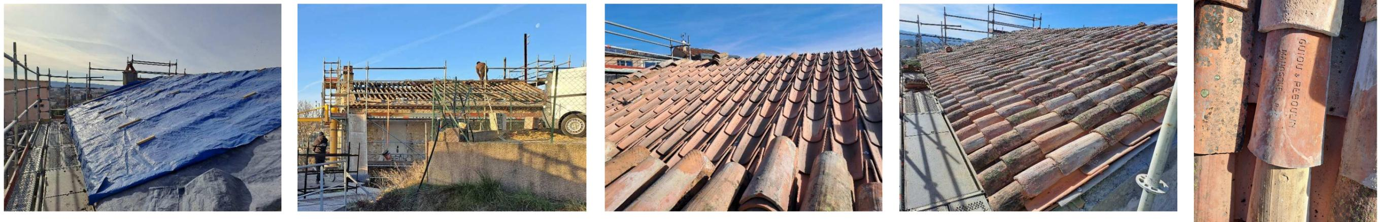
Réfection de la couverture et mise en place des tuiles, terminées
