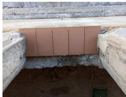
Réfection des linteaux défailants des baies, dépose des menuiseries y compris volets, terminées, et fabrication des nouvelles menuiseries en atelier en cours
