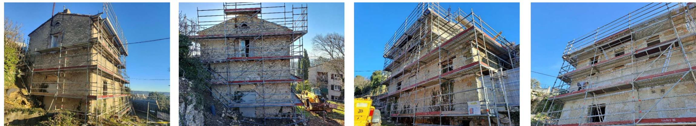
Mise en place de l'échafaudage, purge et décroutage des maçonneries, suppression des fers et éléments parasites, terminés
