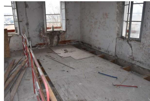
Dépose des cloisons intérieures et du faux-plafond, évacuation des gravats et investigation des lames de plancher, terminées
