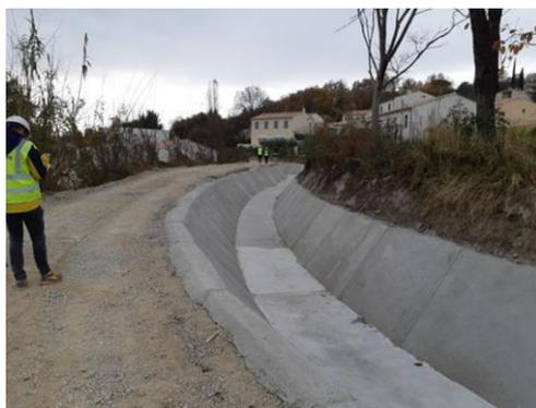
*Reprofilage du canal, mise en place des gabarits, coulage des parois par plots alternés en béton double fibres et du radier, rétablissement des prises d'eau, des pistes et pose des accessoires de sécurité, à Manosque Ouest, lieu-dit « Les Serrets » (MINETTO)*
