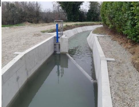
*Construction du seuil hydraulique fixe sur le site Manosque ouest, lieu-dit « Les Serrets » (GAGNERAUD)*
