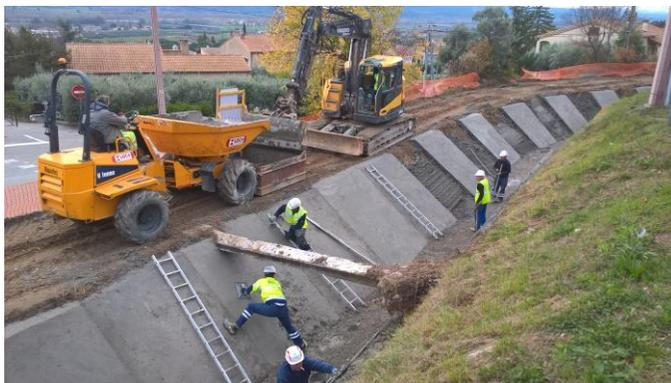
*Mise en place de béton double fibre sur les bajoyers par plots alternés, coulage du radier, traitement de la piste d'exploitation et sécurisation, en amont du site du Largue, à Villeneuve (MINETTO) (Opération n°1 du programme)*
