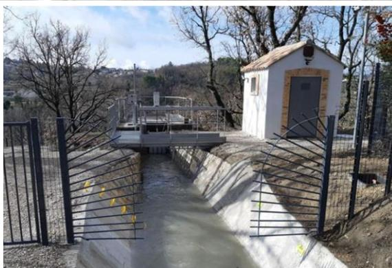
*Pose des vannes, motorisation de la vanne de décharge, construction de l'édicule de commande, armoire de commande et sécurisation des ouvrages sur le site du Ridau à Pierrevert (INEO / GAGNERAUD)*
