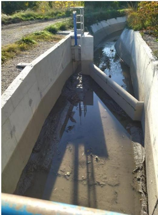
*Seuil hydraulique transversal sur le canal maître, à Manosque, au lieu-dit Les Serrets, au Point Kilométrique 47 450*
