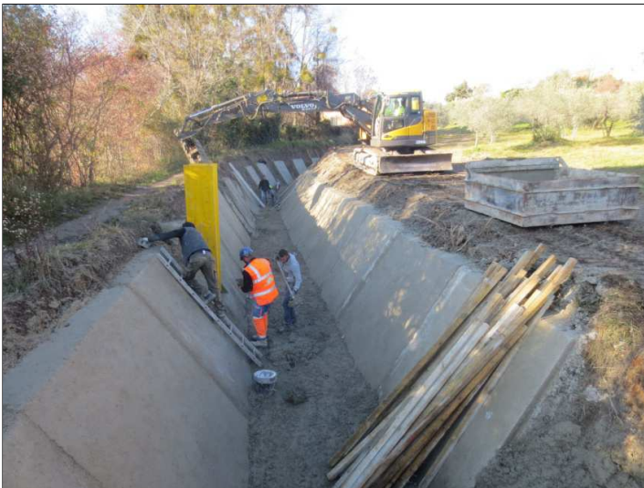
Travaux de reprise de la section courante du canal maître influencée par les ouvrages de régulation - Manosque
