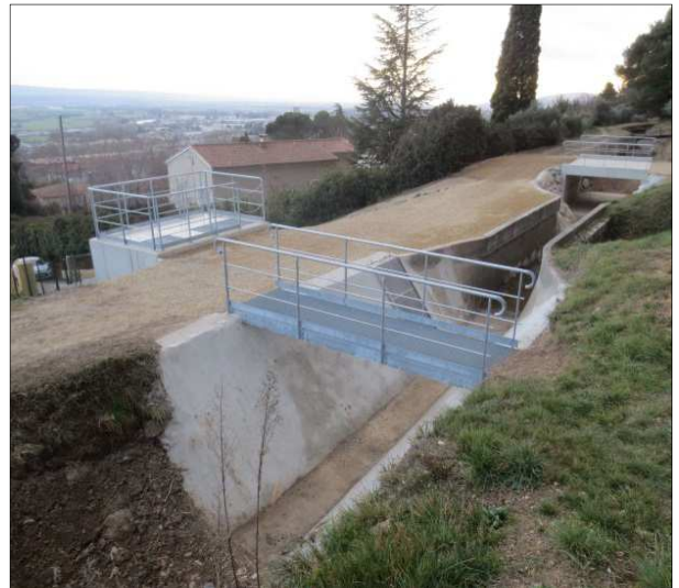
Travaux de réalisation d'une des prises d'eau du nouveau réseau basse pression « Manosque Est » et de ses ouvrages connexes
