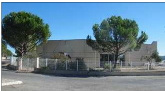
Le bâtiment de l'ASCM à Volx
