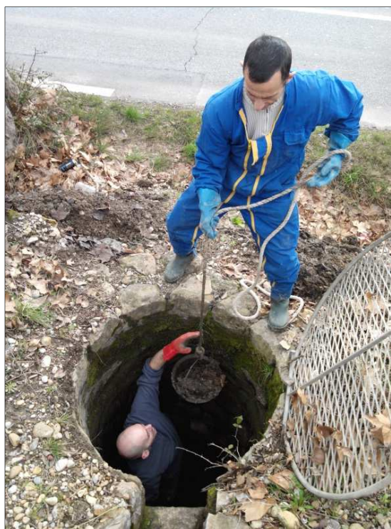
Nettoyage d'un puisard sur filiole
