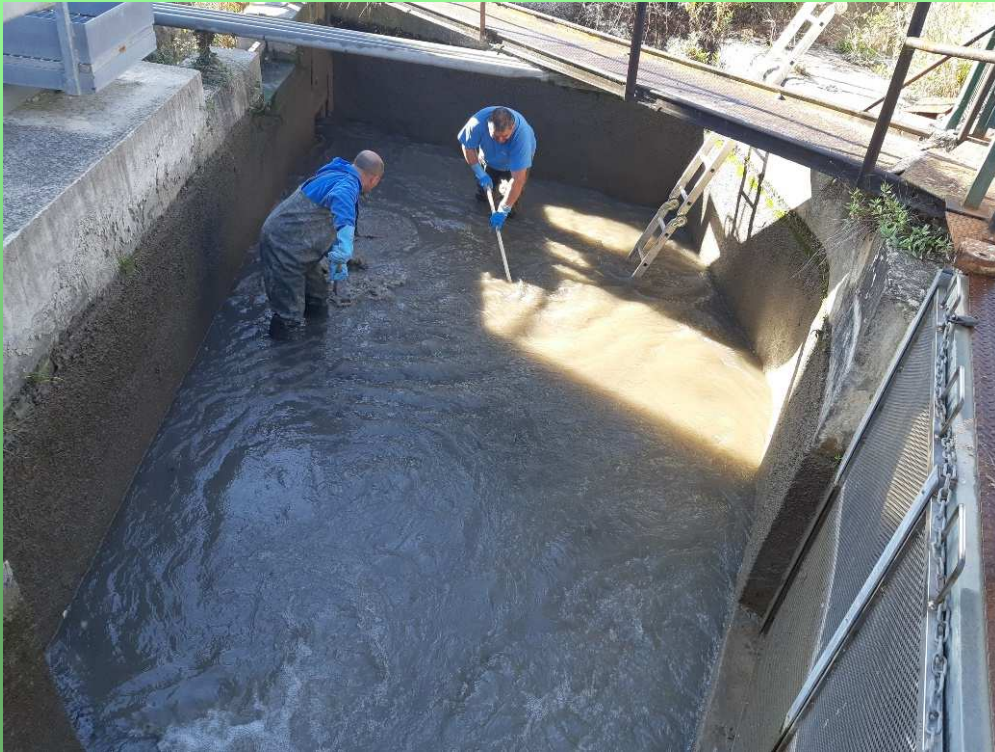
Nettoyage bassin de « la Turbine » à Manosque
