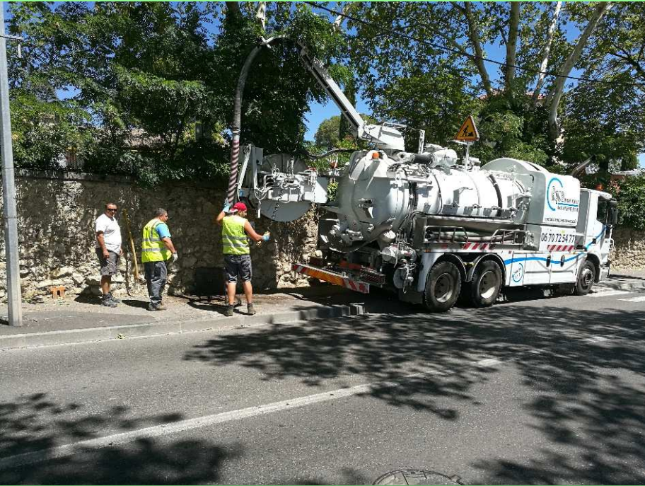
Hydrocurage / coupe racines (ent. ORTEC ou CLOACA MAXIMA)
