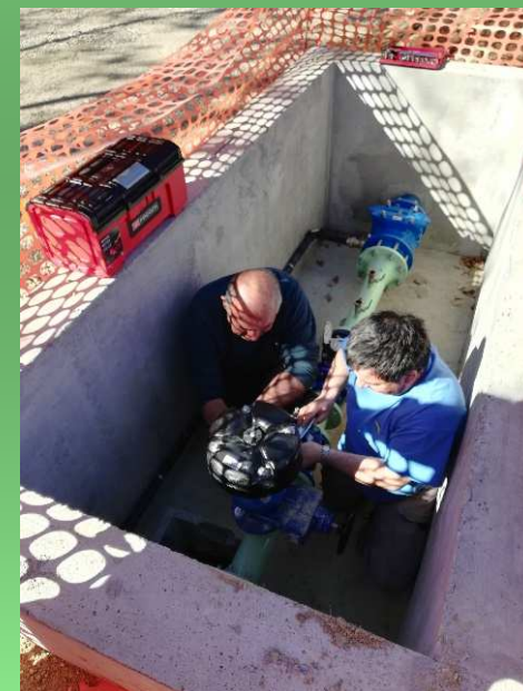
Petits travaux divers (ferronnerie, démontage et contrôle des bornes d'irrigation, petite maçonnerie, changement de martelières, ...)
