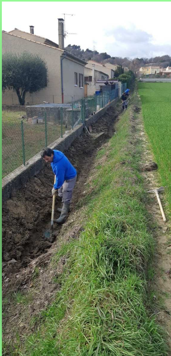
Curage manuel de filioles et de puisards, petite maçonnerie (ASCM)
