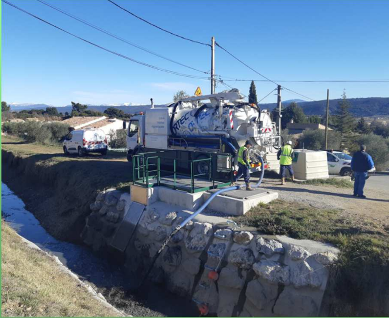
Hydrocurage à Villeneuve, chemin du Pigeonnier de l'Ange (ent. ORTEC)
