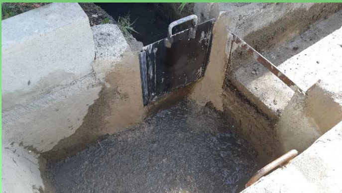
Curage manuel de filioles et de puisards, petite maçonnerie (ASCM)
