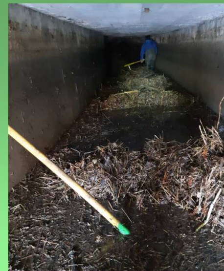
Débouchage de la galerie du Mont d'Or à la remise en eau, février 2022.
