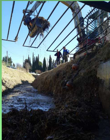
Débouchage de la galerie du Mont d'Or à la remise en eau, février 2022.
