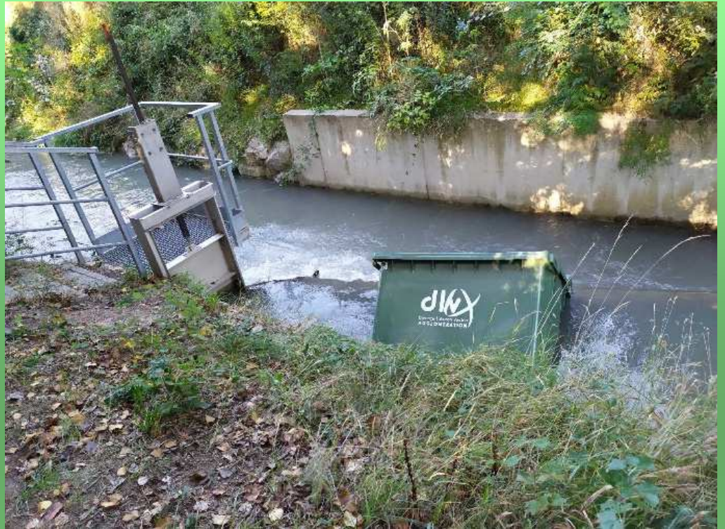
Interventions en cours de saison suite incivilité (ASCM)
