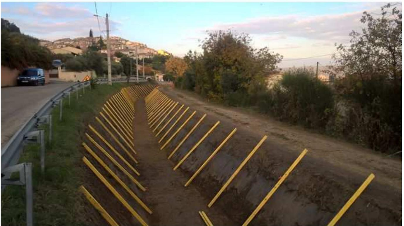
*Reprofilage du canal et préparation des gabarits pour le coulage (MINETTO)*
