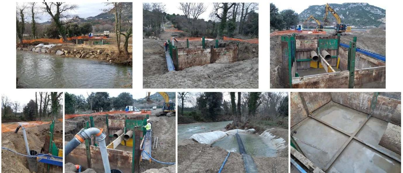
*Reprise des travaux : nouveau bassin provisoire de rétention des eaux avec pose d'enrochements, purge et terrassement repris de la fouille du regard n° 6, travaux de blindage lourds avec mise en place de caissons et augmentation des capacités de pompage, réalisation d'un merlon*
