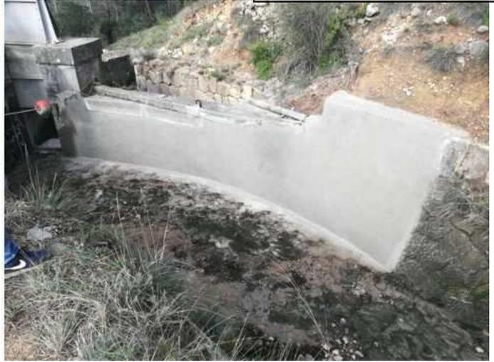
*Reprise d'étanchéité par enduit projeté sur parement en entrée de siphon (PAGLIANO)*
