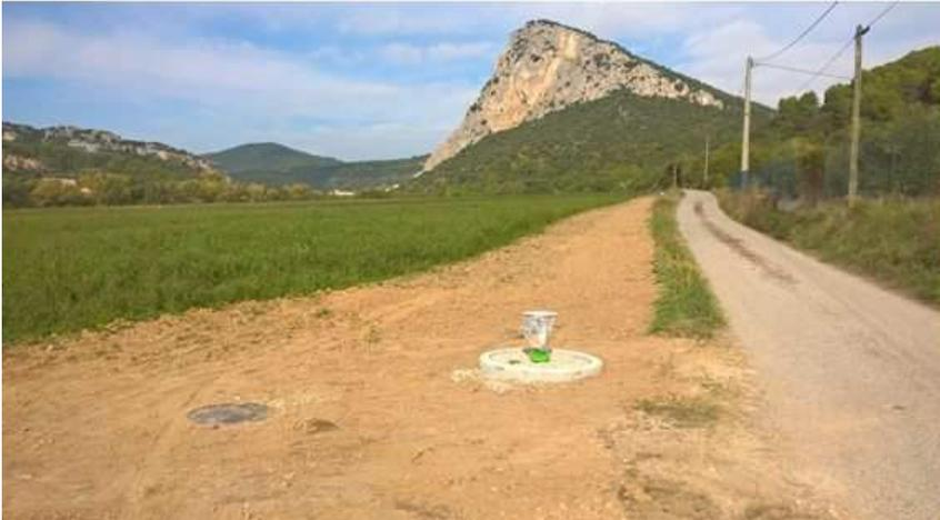
*Pose de conduites fonte et borne d'irrigation en rive gauche du Largue (Provence Alpes Canalisation)*
