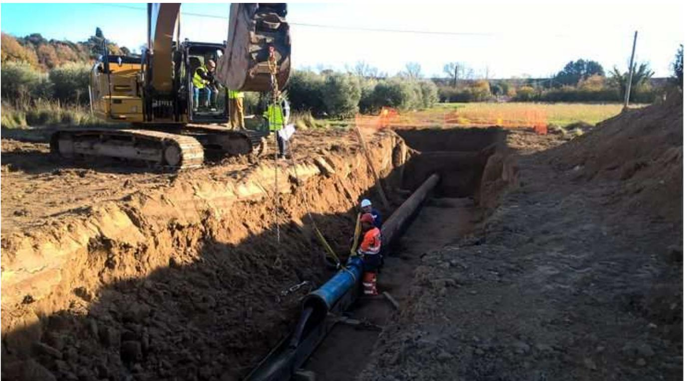
*Réalisation du fonçage sous RD4096 (ST Forages)*
