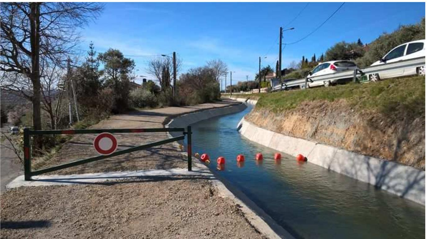
*Mise en place du béton double fibre sur les bajoyers par plots alternés, coulage du radier, traitement de la piste d'exploitation et sécurisation (MINETTO)*
