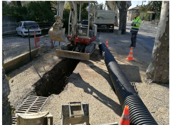
*Confortement de tronçons de filiole à Peyruis, Villeneuve, Volx par réalisation d'un caniveau béton, busage ou reprise d'ouvrages maçonnés (ent. PAGLIANO/MORELLO)*
