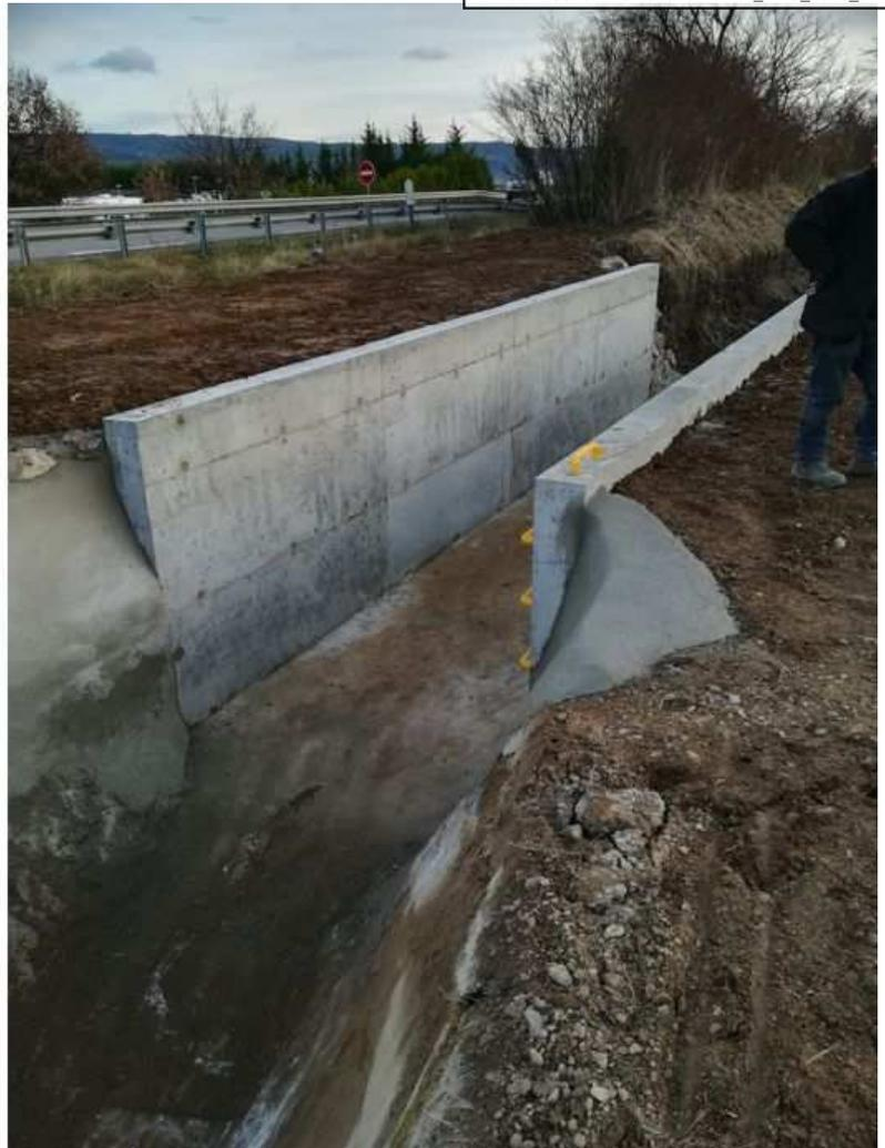
*Réalisation d'un bypass, approfondissement de la conduite AEP et réalisation d'un cadre en béton armé (PAGLIANO)*
