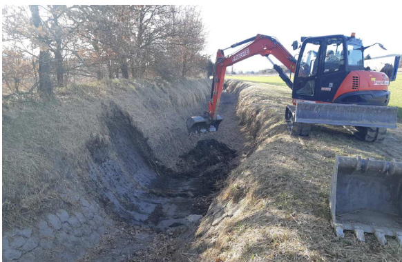
Curage mécanique de tronçons courants et d'ouvrages d'art sur canal maître (PAGLIANO), janvier 2023
