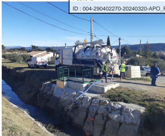
Hydrocurage / coupe racines (ent. AQUAPROVENCE et ORTEC)
