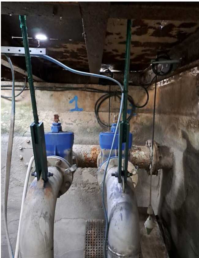
Pompe n°2 après son remplacement avec reprises des fixations des 2 pompes et ajout tresse de terre, février 2023
