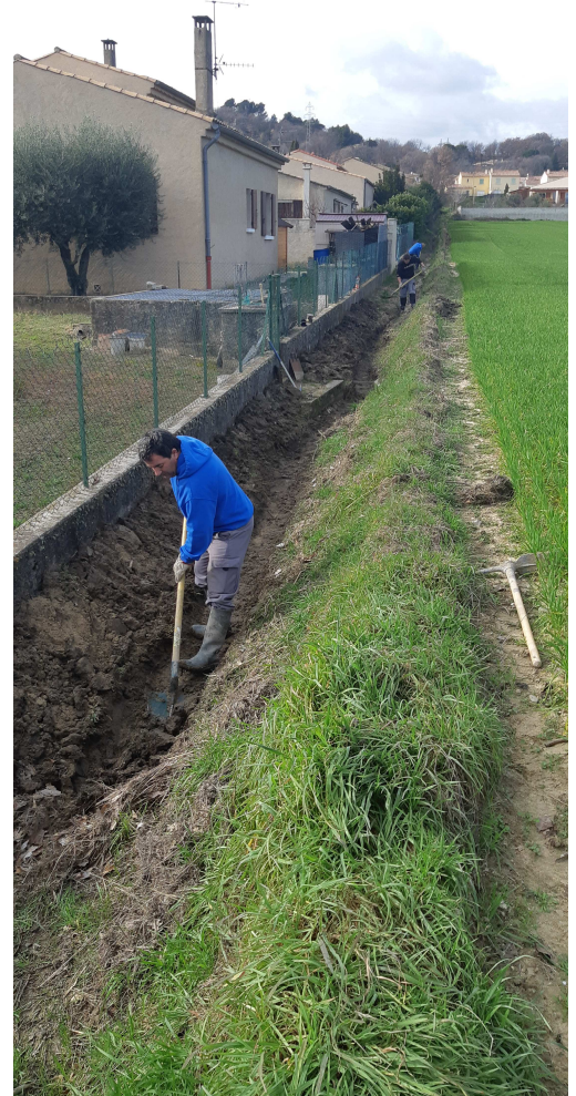
Curage manuel de filioles et de puisards, petite maçonnerie (ASCM)
