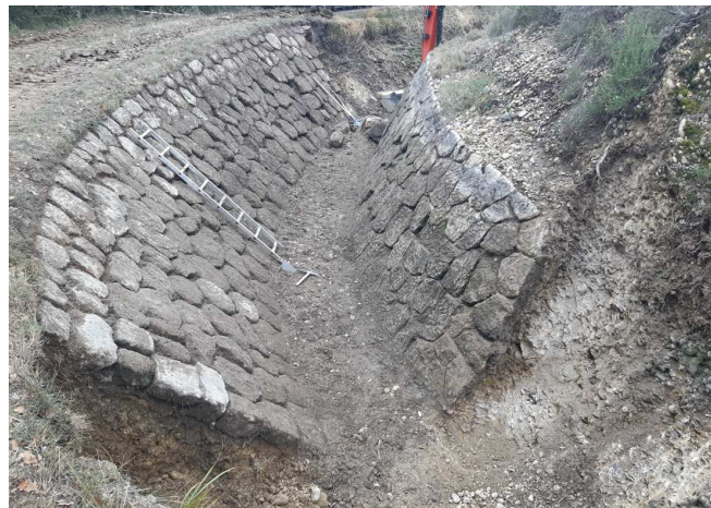
Travaux de terrassement pour réparation de perré sur canal maître aval PK 16-53 (PAGLIANO), décembre 2022
