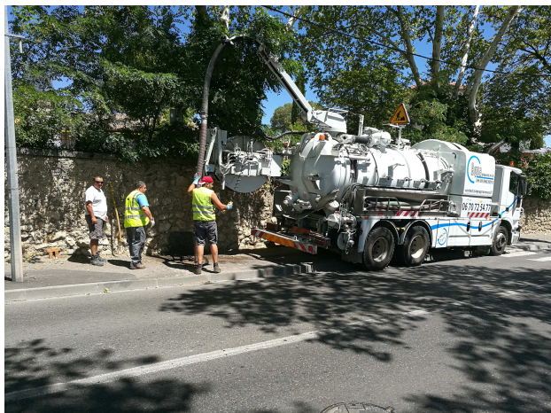
Hydrocurage / coupe racines (ent. AQUAPROVENCE et ORTEC)
