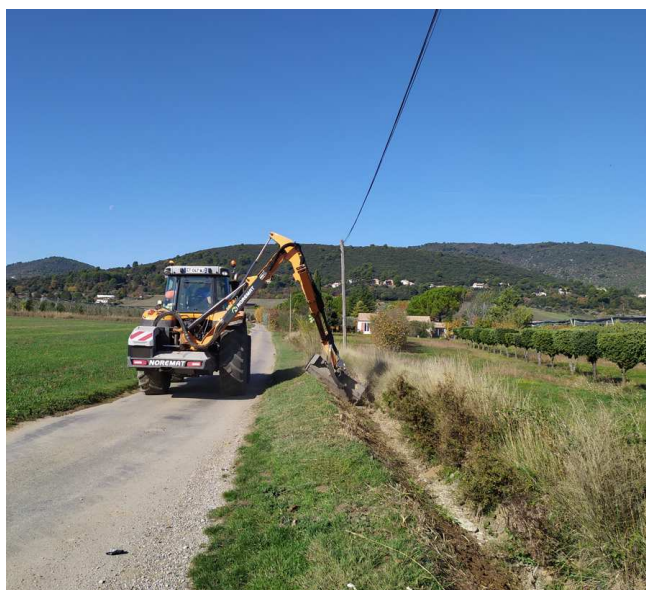
Faucardage hivernal mécanique des filioles et réseaux secondaires (ent. GERVASONI)
