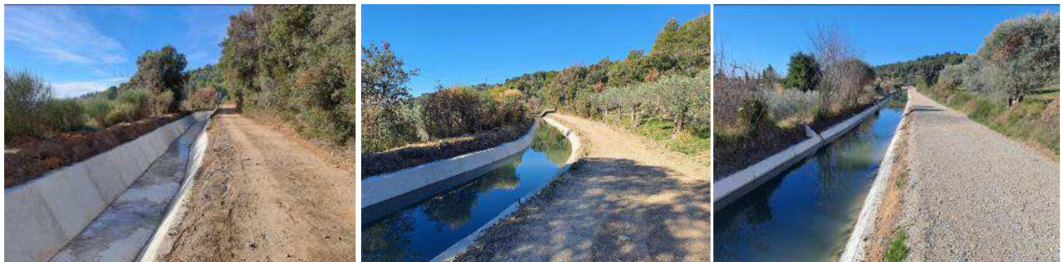
Travaux de cuvelage réceptionnés suite au premier hiver de travaux
