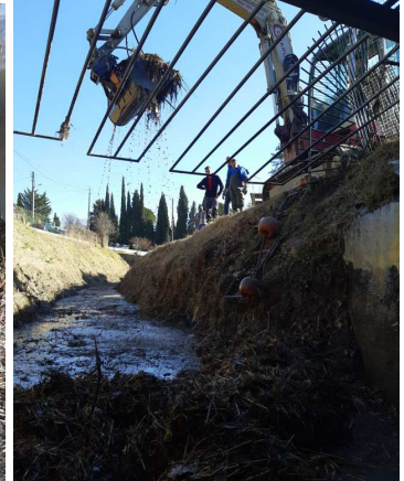
Colmatage galerie du Mont d'Or à Manosque lors de la remise en eau du canal en février 2022
