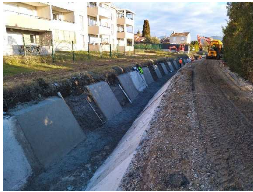
Reprofilage du canal, mise en place de béton double fibre sur les bajoyers par plots alternés et état final
