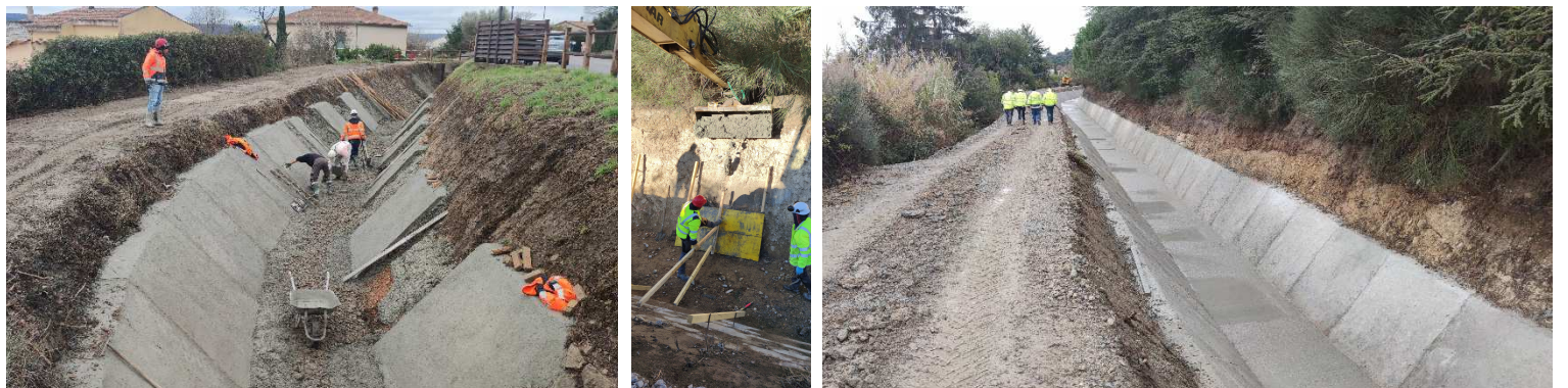
Travaux réalisés avant le 31/12/23 : Reprofilage du canal, mise en place de béton double fibre sur les bajoyers par plots alternés et coulage du radier
