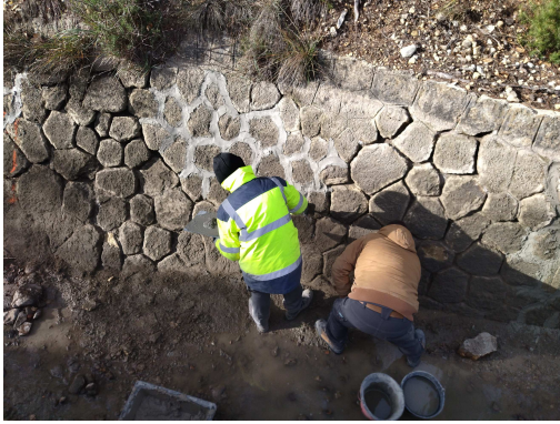
Travaux réalisés en décembre 2023 : Rejointement des perrés et reprise complète des perrés maçonnés
