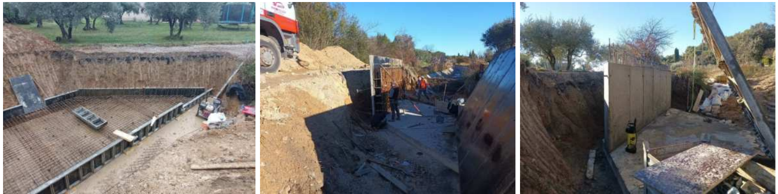
Travaux réalisés en décembre 2023 : Terrassement, coffrage et bétonnage du radier puis des culées
