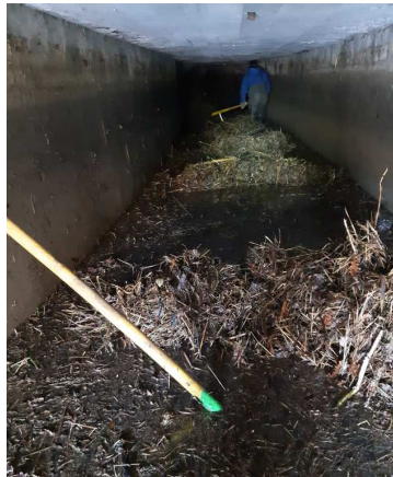
Colmatage galerie du Mont d'Or à Manosque lors de la remise en eau du canal en février 2022
