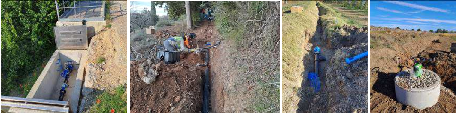
Réalisation des travaux : Création d'un ouvrage de comptage en tête de réseau, mise en place des canalisations et des branchements associés, installation des bornes d'irrigation
