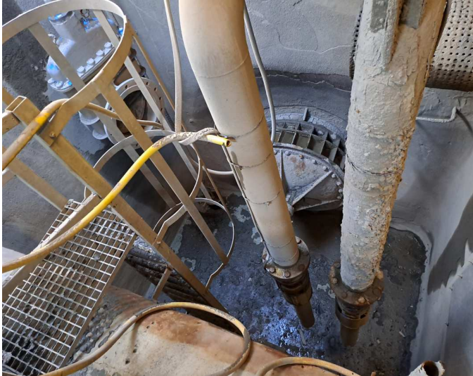
Pompes n°1 et n°2 avant remplacement de la pompe n°2 (à droite sur les photos)
