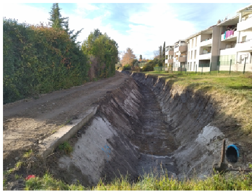
Reprofilage du canal, mise en place de béton double fibre sur les bajoyers par plots alternés et état final
