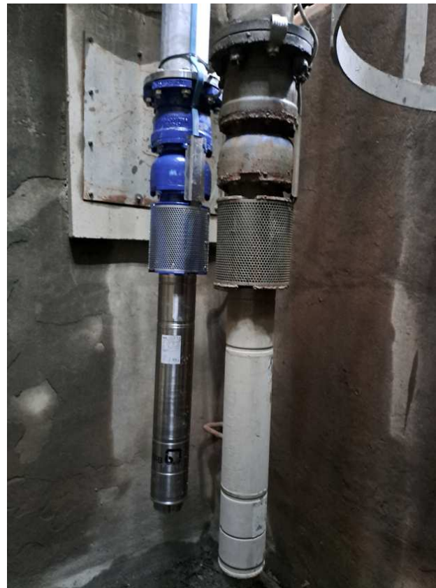
Pompe n°2 après son remplacement avec reprises des fixations des 2 pompes et ajout tresse de terre, février 2023
