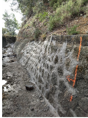
Travaux réalisés en décembre 2023 : Rejointement des perrés et reprise complète des perrés maçonnés
