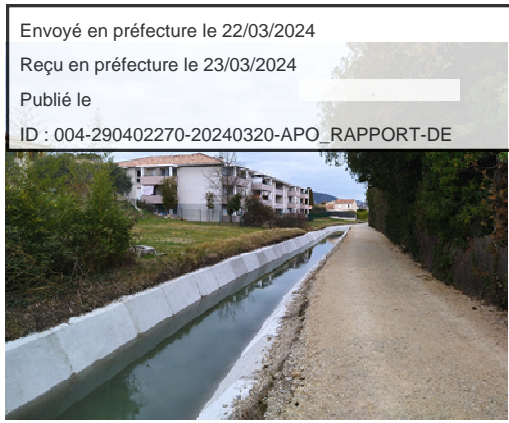
Reprofilage du canal, mise en place de béton double fibre sur les bajoyers par plots alternés et état final
