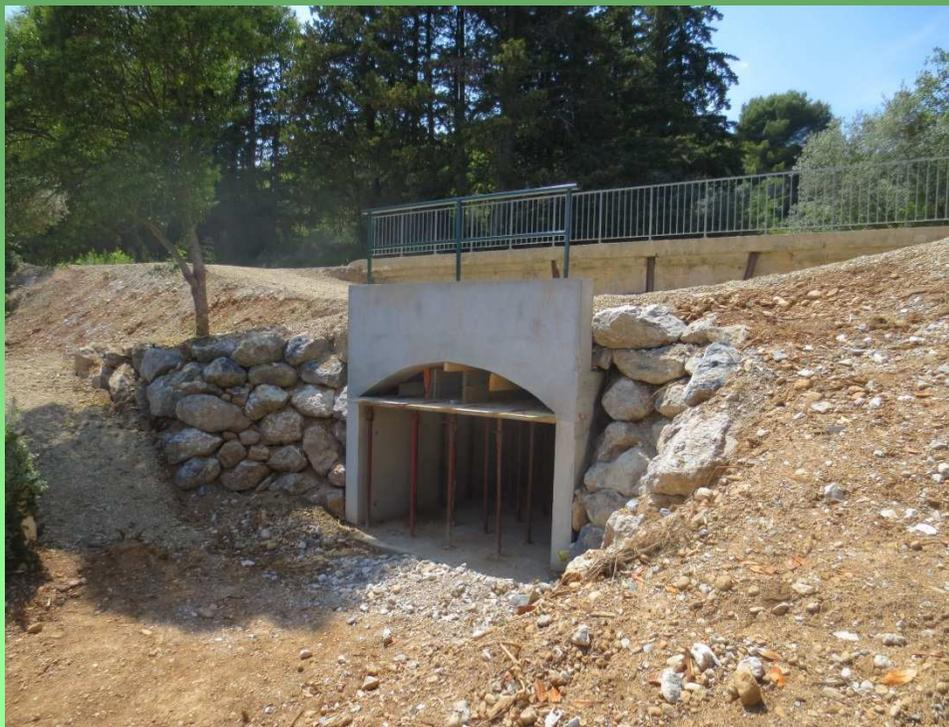
*Réalisation d'un ouvrage de franchissement latéral à l'aqueduc PK 42,703 – travaux préparatoires au recuvelage du tronçon phase 2*
