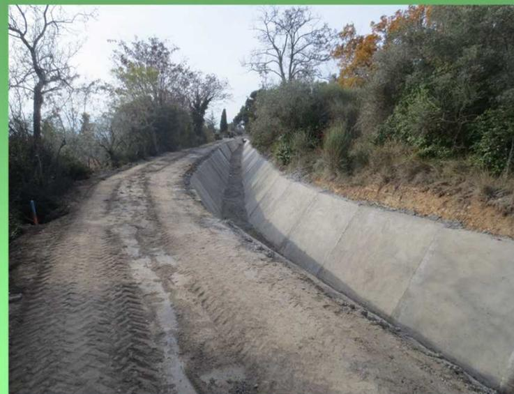
*Bétonnage par coulage de plots alternés sur les bajoyers (béton double fibre)*
