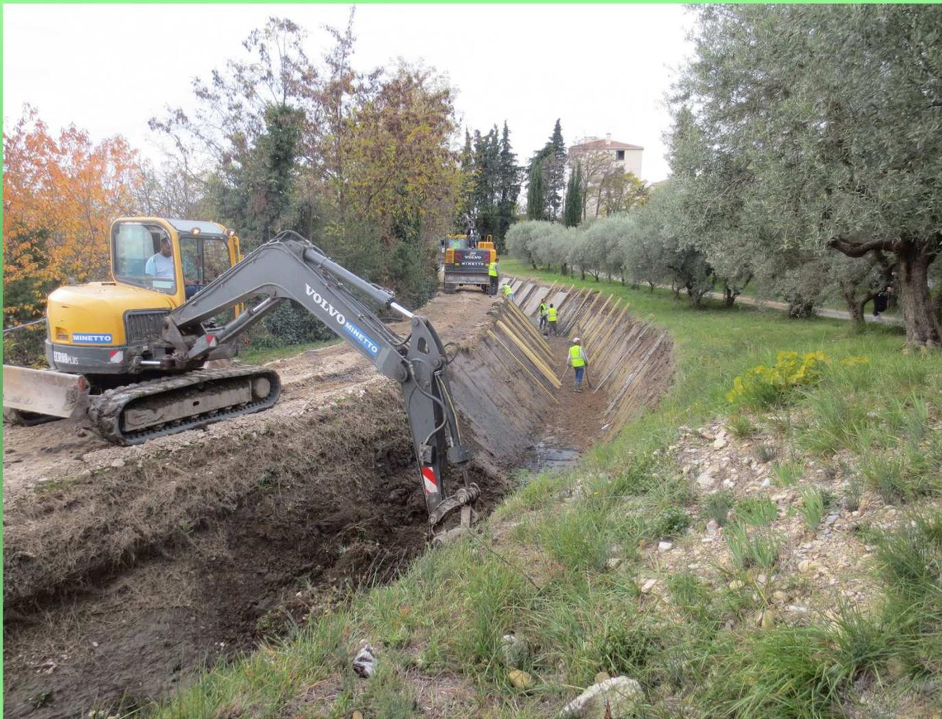
*Reprofilage des berges, alignement et réglage des gabarits pour mise en œuvre des bétons*
