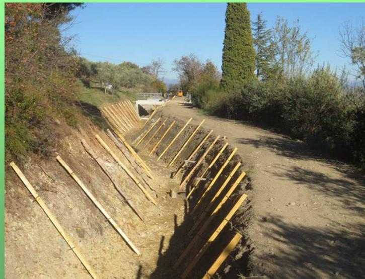
*Travaux de préparation et de recalibrage du canal (reprofilage du radier, dressage des talus, alignement et mise en place des gabarits pour coulage des bétons)*
