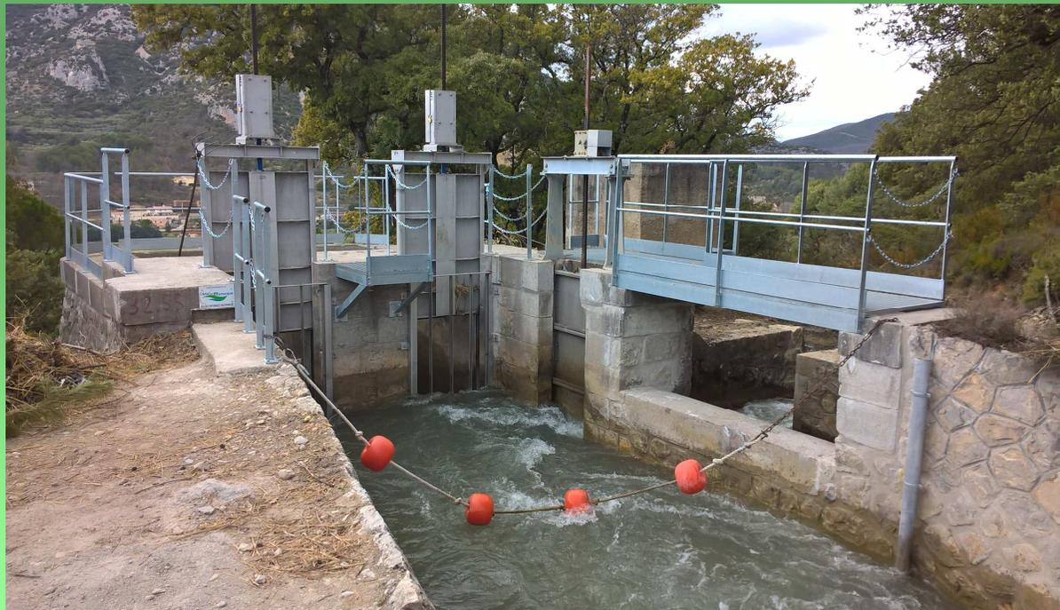
*Curage des puits, reprise des maçonneries et remplacement des équipements et de la ventellerie de la tête amont (GTM Sud / CIC ORIO)*
