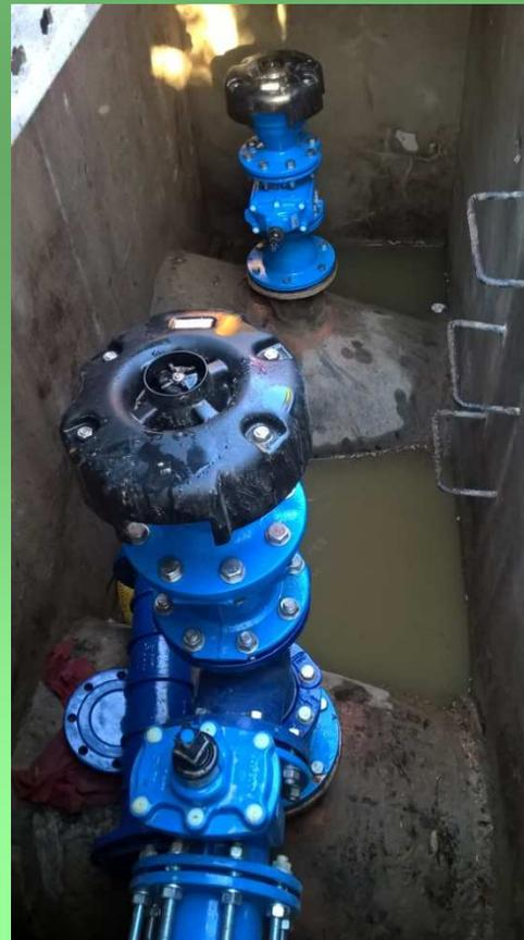
*Démontage des pelles, des ventouses et dépose de la vanne de vidange avant remplacement par des équipements neufs (CIC ORIO)*
