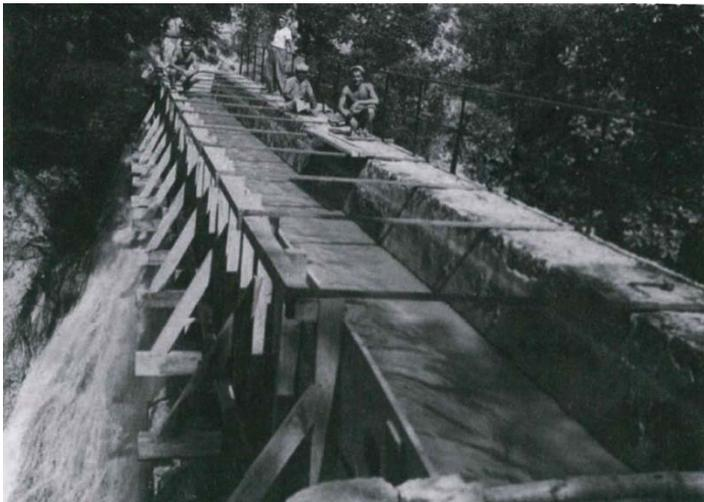
Avarie de l'aqueduc de Giropey en 1942, avec une réparation provisoire par la mise en place d'une bache en bois
