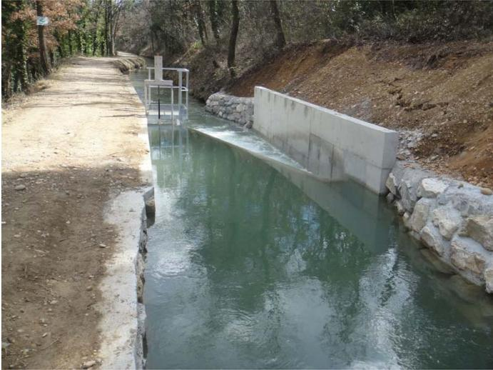
Seuil transversal fixe permettant de maintenir une ligne d'eau minimale en amont
