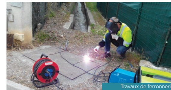
Travaux de ferronnerie
