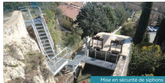
Mise en sécurité de siphons
