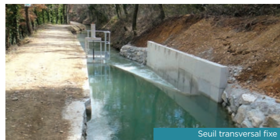
Seuil transversal fixe
