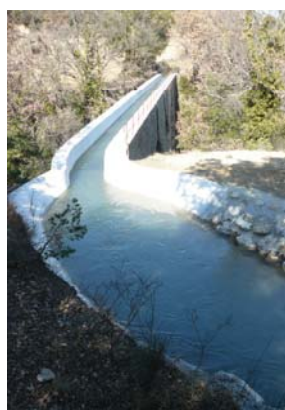
L'aqueduc Saint-Saturnin suite aux travaux de reprise de l'étanchéité intérieure
