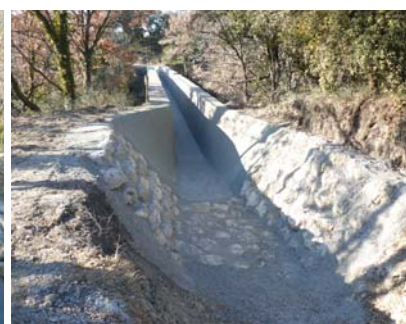
L'aqueduc Saint-Saturnin suite aux travaux de reprise de l'étanchéité intérieure
