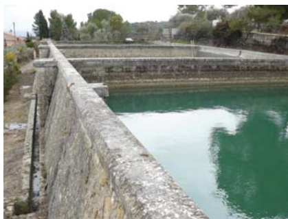
Curage et reprise de l'étanchéité intérieure d'un bassin alimentant un réseau de la ville de Manosque
