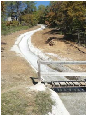
Coursier du siphon du Lauzon après travaux
