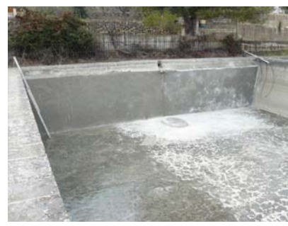
Curage et reprise de l'étanchéité intérieure d'un bassin alimentant un réseau de la ville de Manosque
