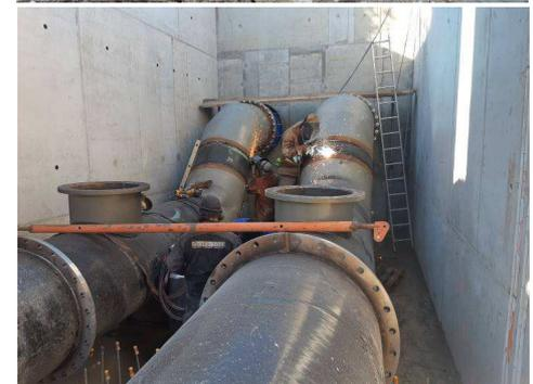
Mise en œuvre des travaux par demi-rivière, dépose et remplacement des canalisations, génie-civil et appareillages des regards
