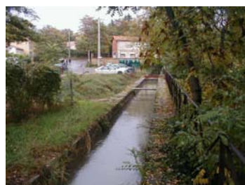
Aqueduc d'Espel avant travaux
