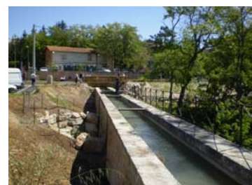
Aqueduc d'Espel après travaux
