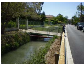
Boulevard des Amandiers après travaux
