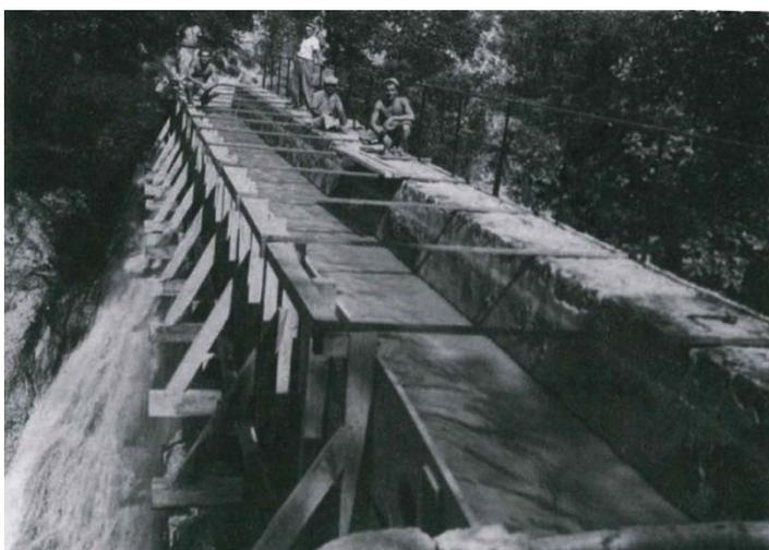
Avarie de l'aqueduc de Giropey en 1942, avec une réparation provisoire par la mise en place d'une bête en bois
