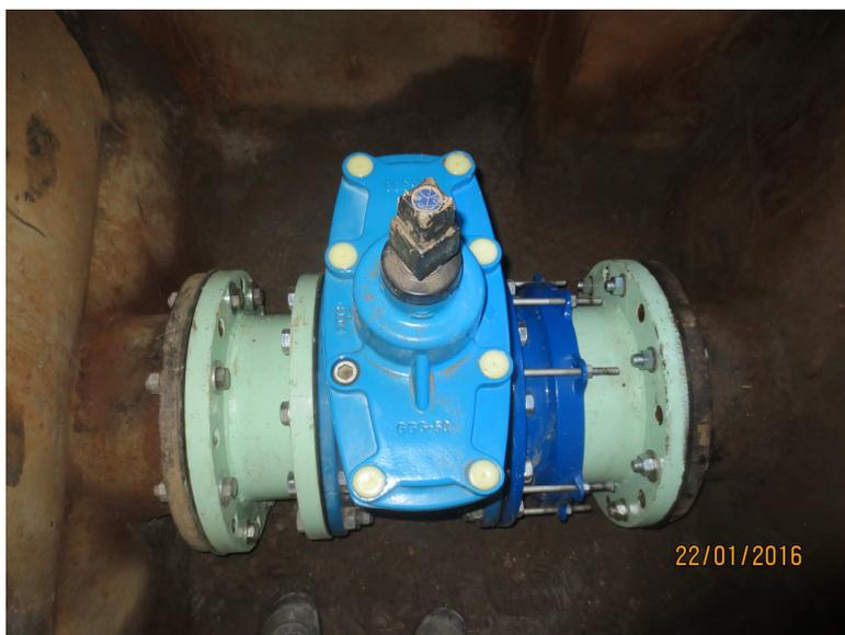
*Vue du montage « sur mesure » de la nouvelle vanne de sectionnement de l'une des 4 vidanges du siphon du Largue*
