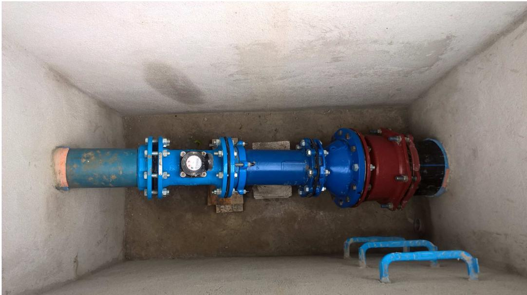
*Vue d'une ligne de tuyauterie équipée d'un compteur à hélice tangentielle mise en place sous la prise « Embarrades » à Manosque.*
