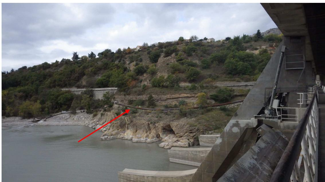
A la fin des travaux, l'opération de dépose du siphon et de rétablissement de l'alimentation du canal de Manosque par sa nouvelle vanne a été réalisée les 16 et 17 août. Deux coupures de 4 heures ont été nécessaires, sans incidences notables sur la desserte en eau brute.
