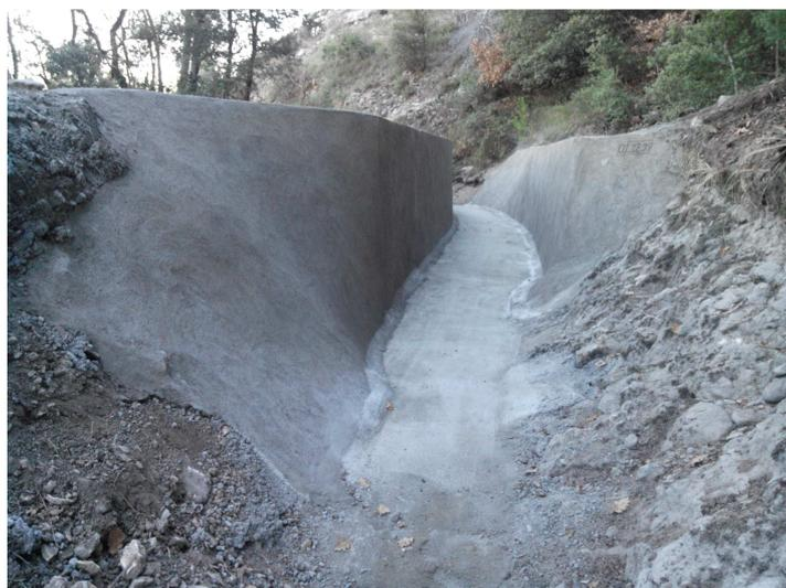
Réhabilitation de l'étanchéité d'un aqueduc par décroustage et réfection de la cunette interne avec un enduit étanche projeté sur grillage (ent. PAGLIANO/MORELLO)
