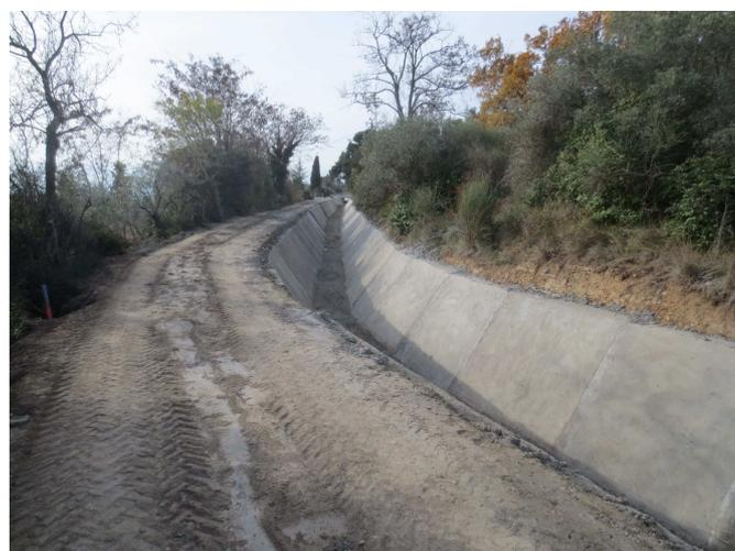
*Bétonnage par coulage de plots alternés sur les bajoyers (béton double fibre)*
