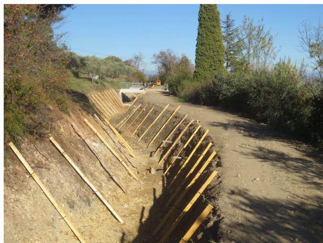
*Travaux de préparation et de recalibrage du canal (reprofilage du radier, dressage des talus, alignement et mise en place des gabarits pour coulage des bétons)*
